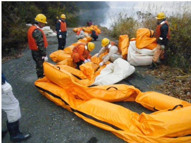
オイルフェンス結束状況
