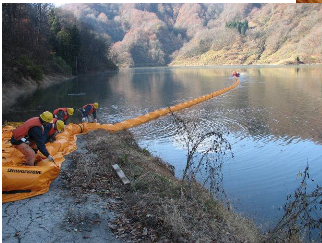
オイルフェンス設置状況
