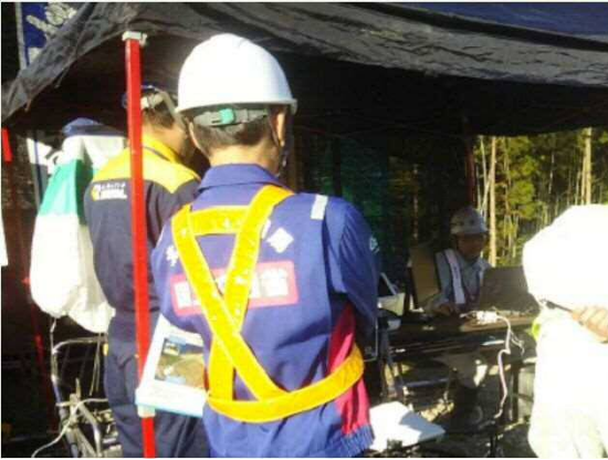
ICT活用工事の概要説明
