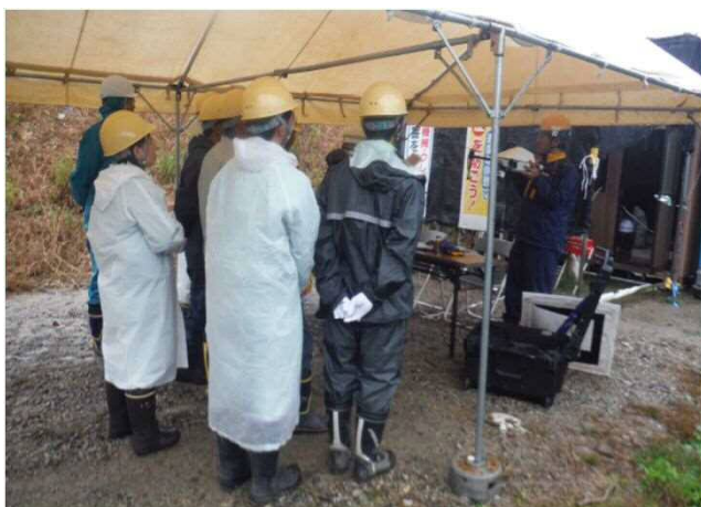
ドローンによる起工測量の概要説明
