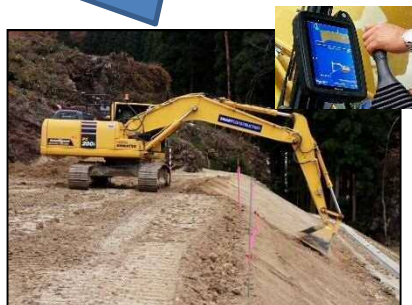
②ICT建機 法面作業状況
