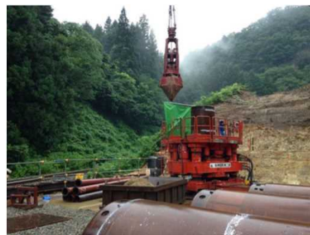
A1橋台下部 掘削状況
