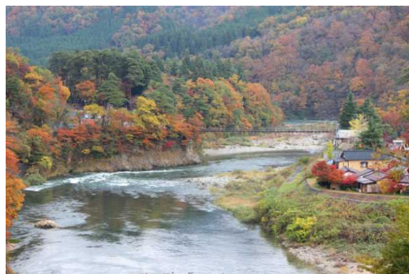
現場から望む、晩秋の鷹ノ巣温泉と吊り橋 (鷹ノ巣温泉喜久屋様の提供写真)
