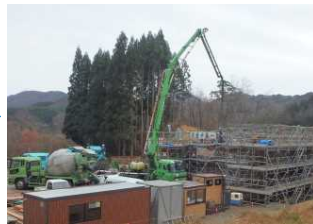
【ポンプ車でコンクリート打設】
