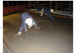
【丁寧なコンクリート表面仕上げ】
