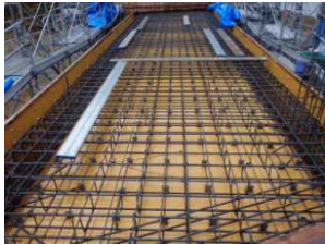
【正確に組み立てられた鉄筋】
