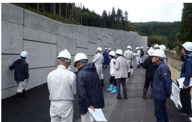
補強土壁（テールアルメ）
