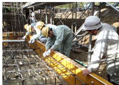
鉄筋間隔や直径を設計図と照合
