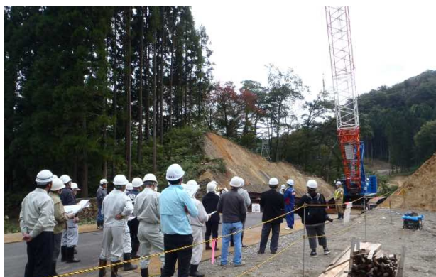
120 t 吊のクローラクレーン
