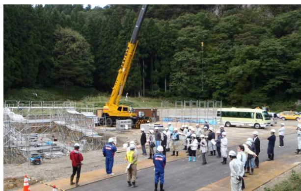
ボックスカルバートの現場
