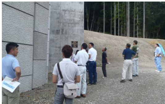
間近から見る補強土壁と橋の下部
