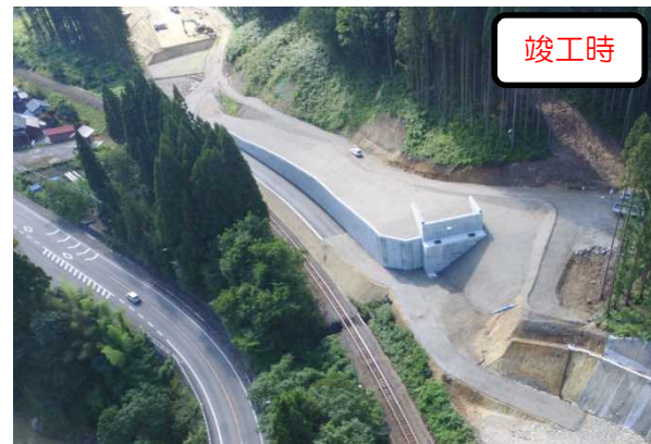
【本工事で橋台と補強土壁などを施工】
