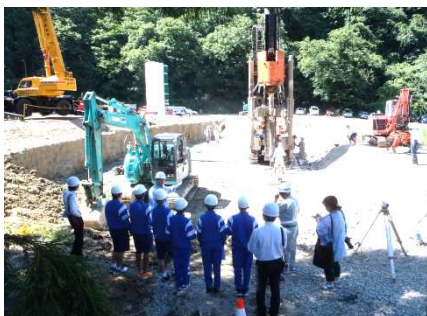
地盤改良工事見学
