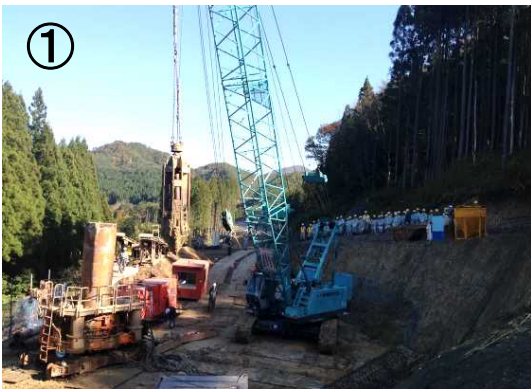
① 杭の掘削作業 (H27年10月)
