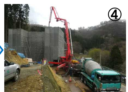
④ コンクリート施工 (H28年4月)
