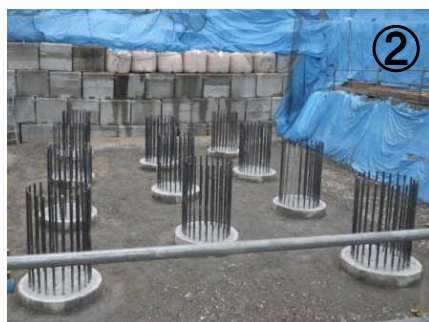
② 杭の出来上がり (H27年12月)
