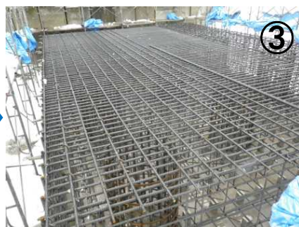
③ 鉄筋の組み立て (H28年1月)
