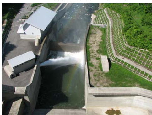
▲利水放流設備からの放流
