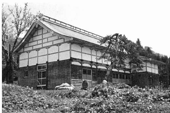
屋根葺き替えした移転前の済広寺（昭和59年）
