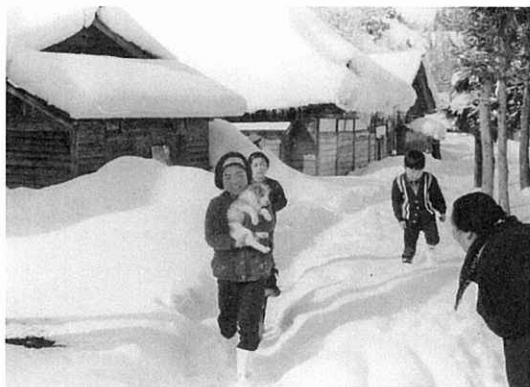
市野々ポンプ庫前(昭和44年)
