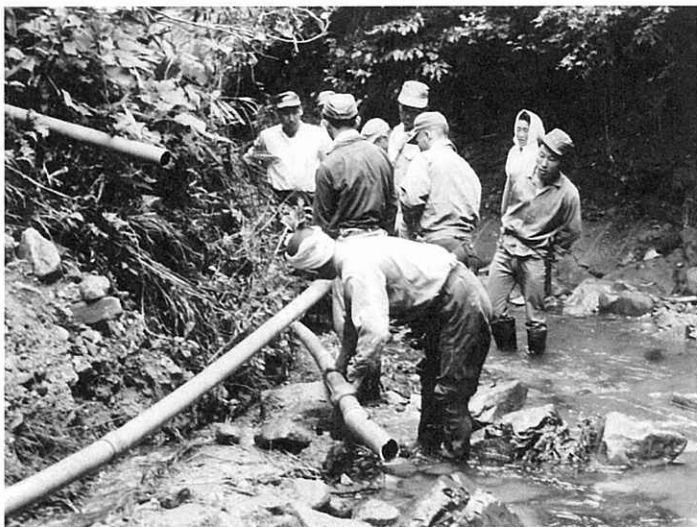
簡易水道の敷設工事（市野々・昭和37年）
