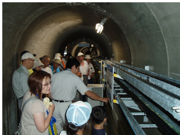
横川ダム内部（監査廊）の説明
