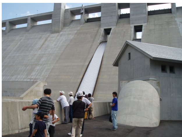
横川ダム下流部から（オリフィスからの放流）
