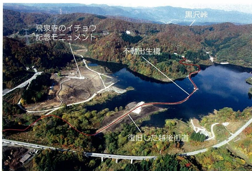
写真 5.6-2 新街道の状況
