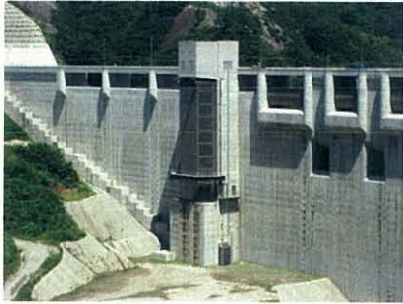
選択取水設備
