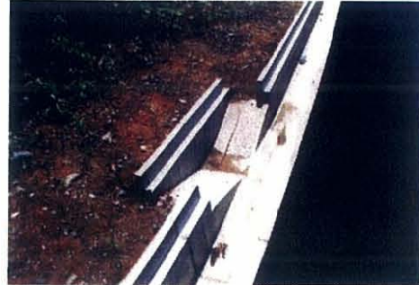
排水側溝の傾斜
