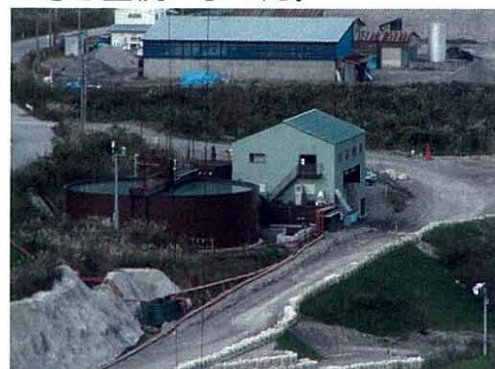
濁水処理施設の設置
