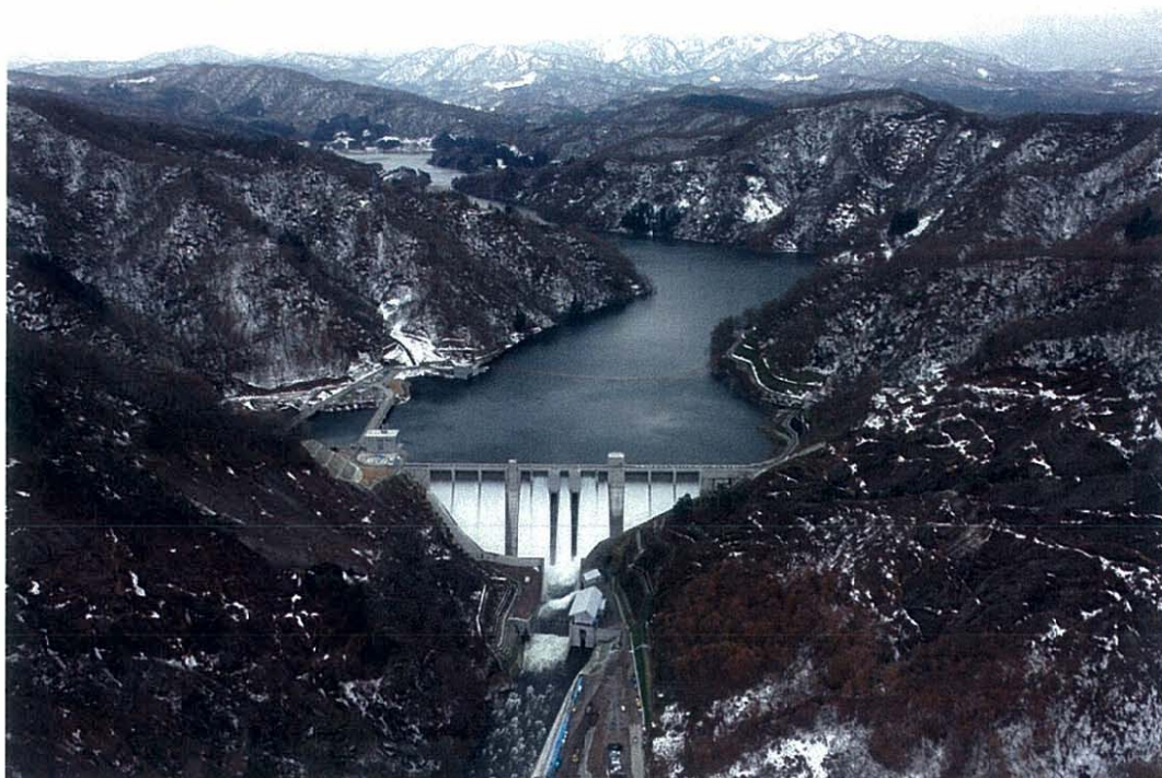
写真 1-1 横川ダムの状況(平成 19 年 11 月 27 日撮影)
