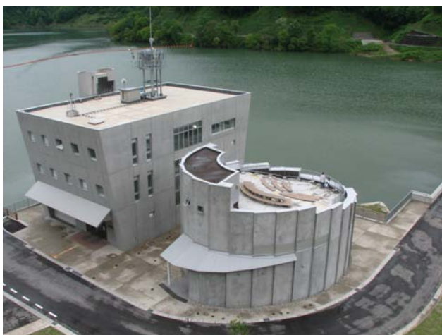
横川ダム管理支所（奥）と きてくろ館（手前）
