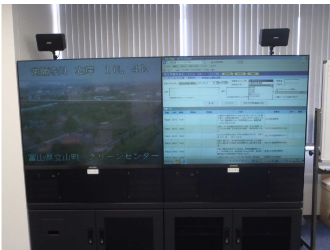
大型モニターにより現地映像等を周知
