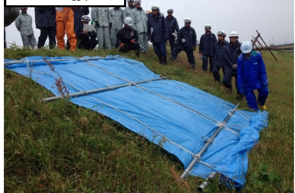
シート張り工
