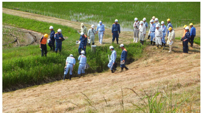
神通川 漏水箇所の確認状況
