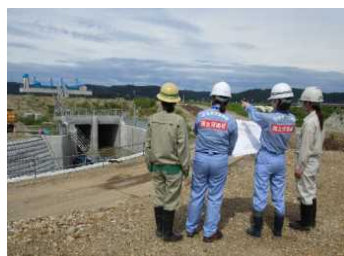
工事の施工調整について 4者協議
