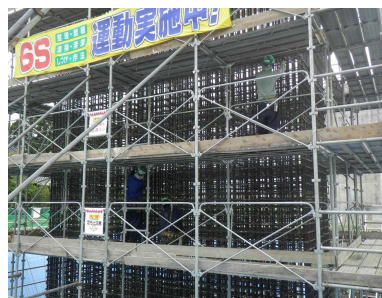
橋脚鉄筋組立状況
