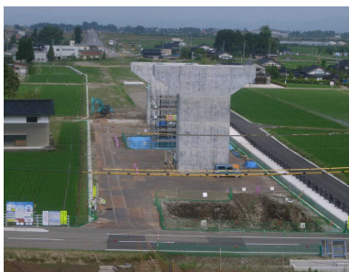
いかるぎの大橋橋脚施工状況
