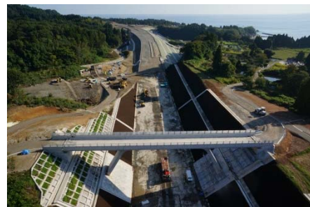
完成間近の脇跨道橋
