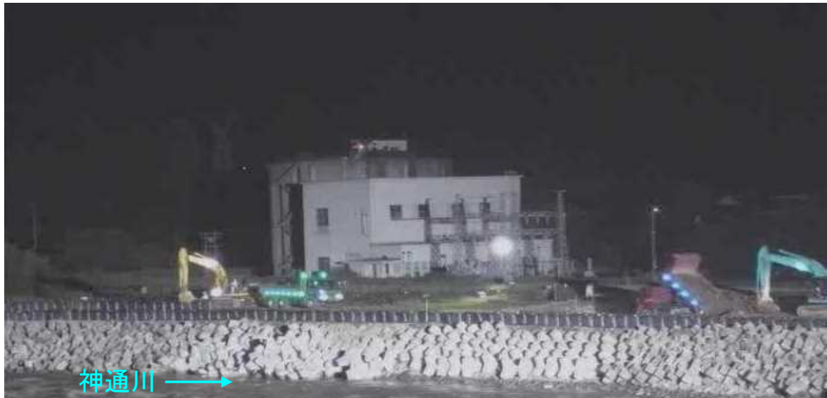
夜間作業状況（平成30年7月10日 00時57分）
