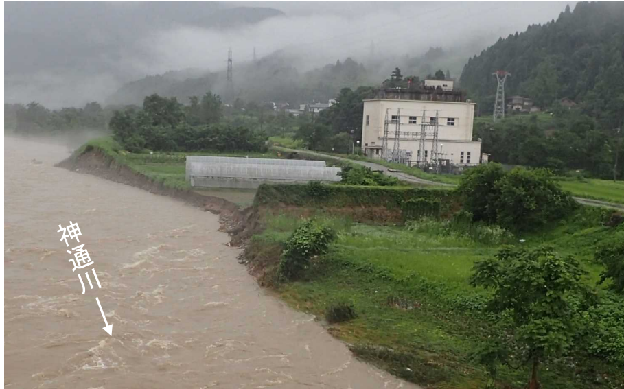
被災状況（平成30年7月7日 7時00分）
