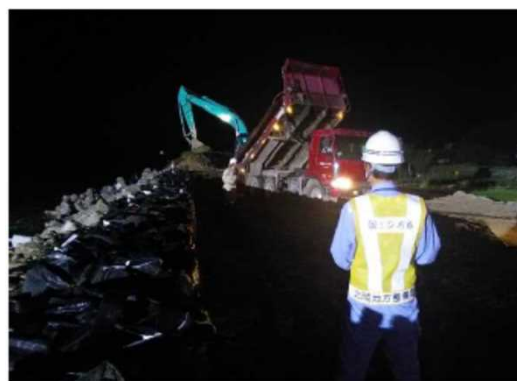
復旧状況 撮影日2018.7.9 20時52分
