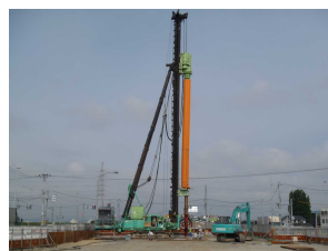
地盤改良機（高さ約30m）
