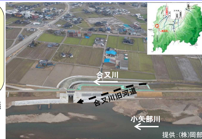
合流点処理完成写真(小矢部川左岸から右岸を望む) 提供:(株)岡部
