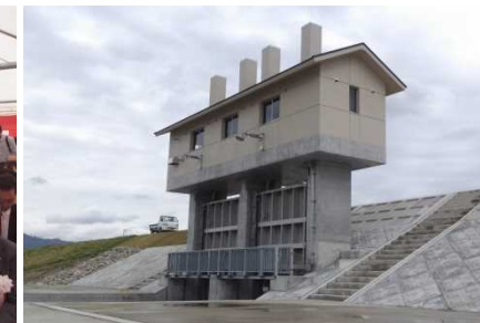
合又川排水樋門ゲートと上屋
