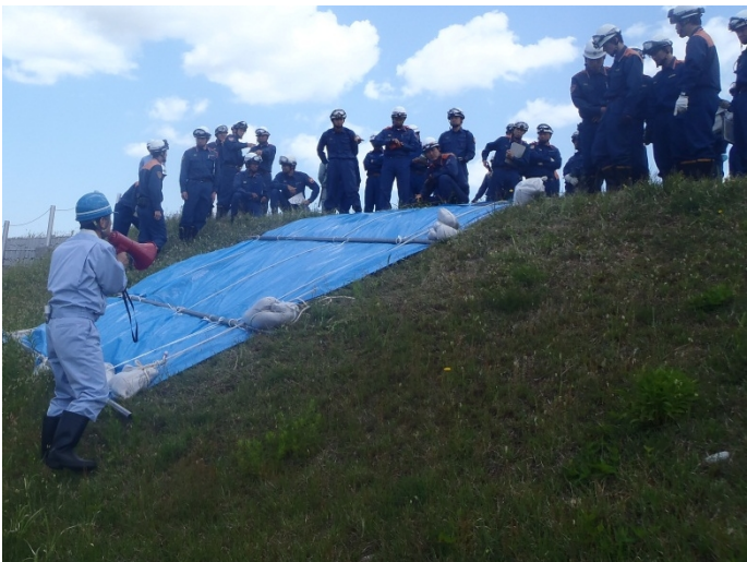
シート張り工 作業状況
