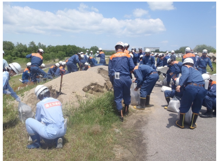
積み土のう工 作業状況
