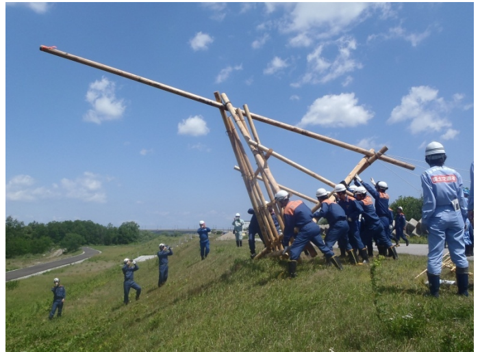
川倉工 組み立て後の投入状況
