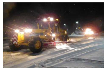
夜を徹して作業にあたる除雪グレーダ (国道8号小矢部市安楽寺地先)
