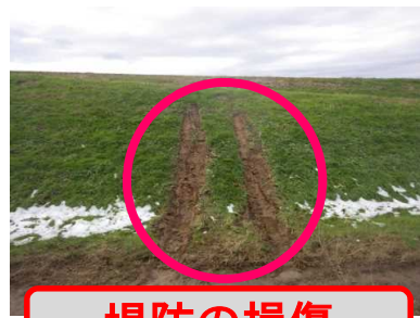
堤防の損傷
