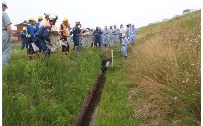
神通川 漏水箇所の確認状況
