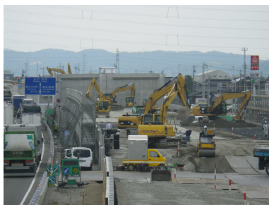
補強土壁施工状況
