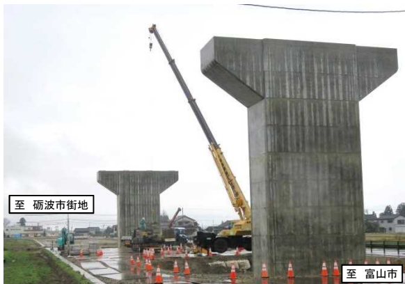
いかるぎの大橋下部工事の施工状況
