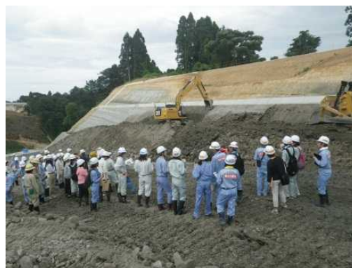
中波地区で情報化施工を見学
