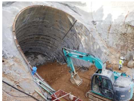
橋脚基礎工「斜め深礎杭」の施工状況
