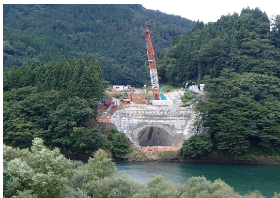
工事の状況(対岸から撮影)
