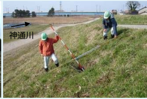
神通川 平常時の巡視・点検状況 (富山市上野新)
