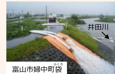
H25.9洪水でのポンプ排水及び照明車配備
