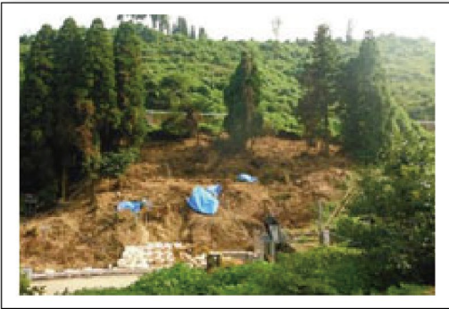
土砂崩れ（安楽寺地区 平成25年8月1日発生）
