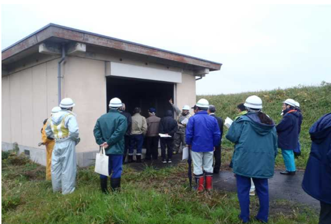
神通川 点検状況
