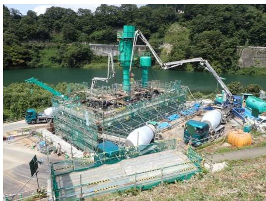
橋梁下部工事の状況
