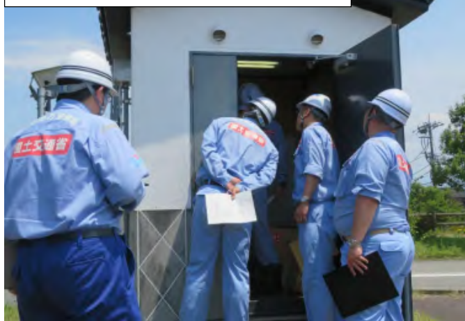
R1庄川 大門水位流量観測所点検状況
