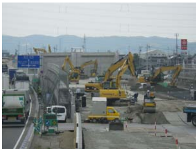
大規模な補強土壁の施工状況
