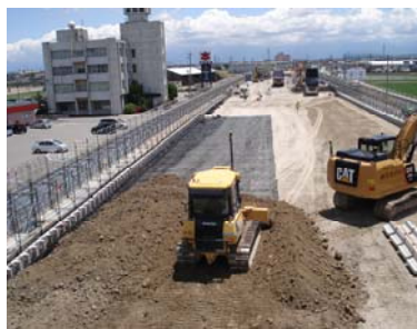
情報化施工の状況
