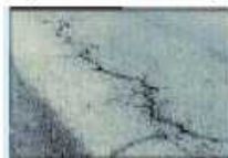
舗装のひび割れ
