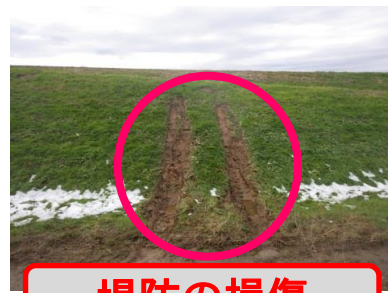
堤防の損傷
