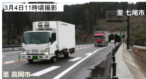
写真：七尾氷見道路を走る物流トラック
