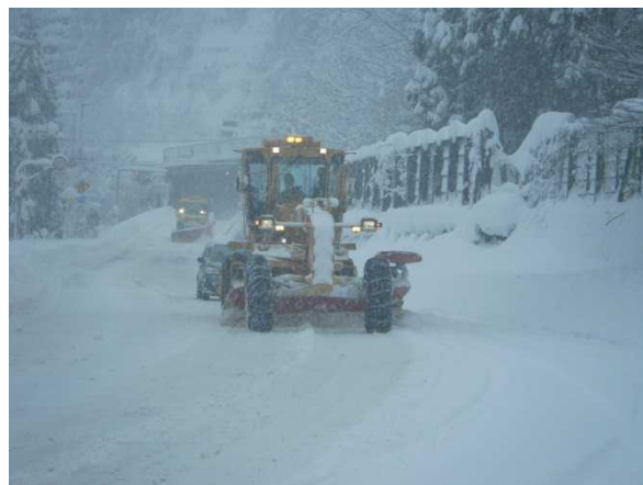
降りしきる雪の中で道路の確保にあたる除雪グレーダ (国道41号富山市猪谷地先)
