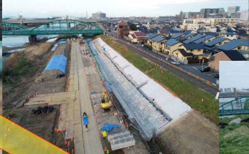
③ 新設護岸設置 (令和2年3月)
