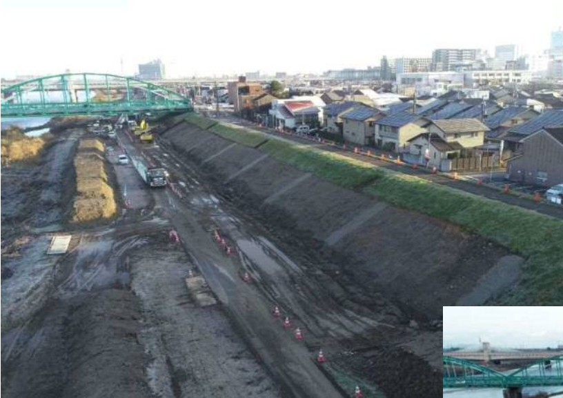
② 既設護岸撤去 (令和元年11月)
