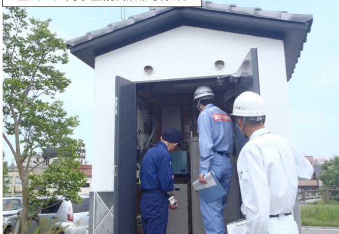
庄川 大門水位観測所点検状況
