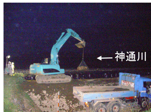
袋詰玉石設置状況（平成30年7月10日 20時頃）
