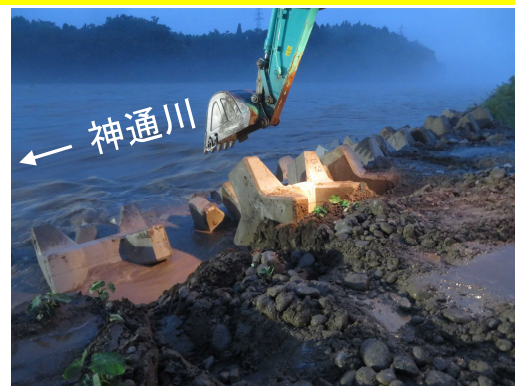
ブロック投入状況（平成30年7月7日 19時頃）
