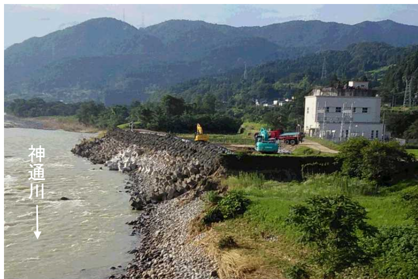
復旧状況（平成30年7月11日 7時00分）
