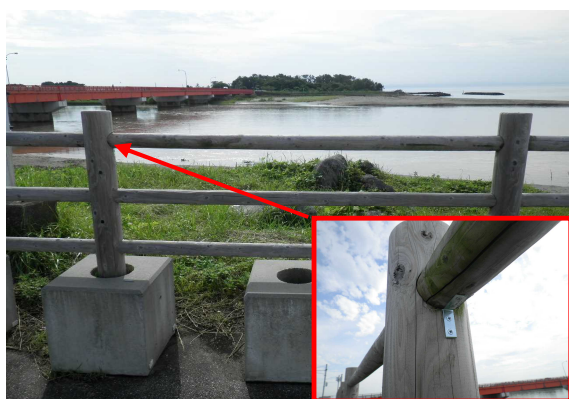
立入防止柵の補修
