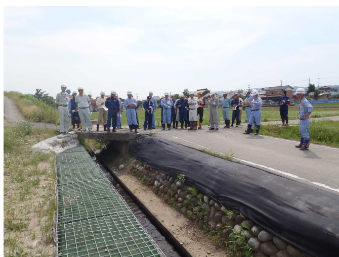
神通川 漏水対策箇所の確認状況
